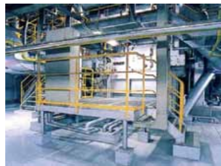
⑤長時間の安定運転 焼却炉の床に配置された水平ストーカがスムーズに動いてごみの攪拌・ときほぐしを確実にし、同時に火格子の先端より空気を常時供給するため、ごみを完全燃焼させ有害物質の発生を防ぎます。また自動燃焼制御（ACC）によって、最適な燃焼状態を維持します。
