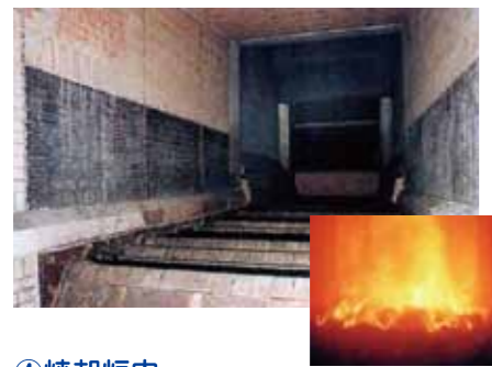
④焼却炉内 炉床の水平ストーカの特殊運動により、ごみを完全燃焼します。
