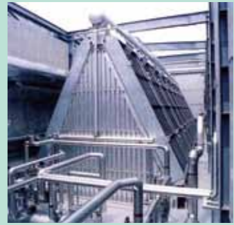
●タービン排気復水器 タービン発電機で利用した蒸気を水に還元します。
