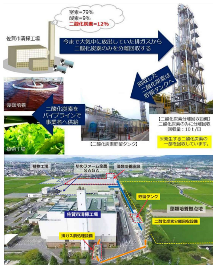
図 4-4-5 ごみ焼却処理施設における CO 2 回収技術導入事例 (佐賀市)
