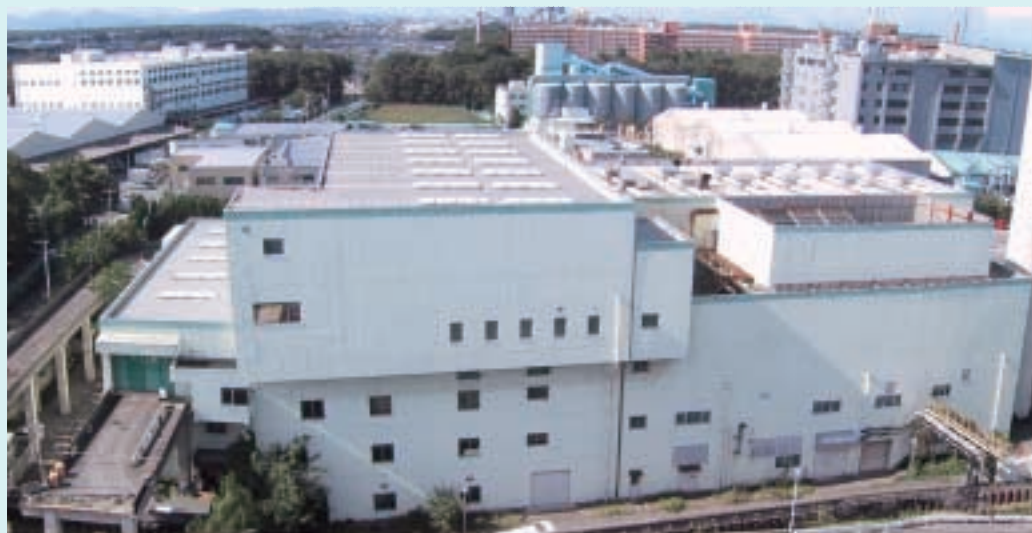
解体される工場
