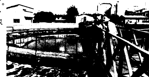
▲槽の中の微生物がし尿をきれいにします。
