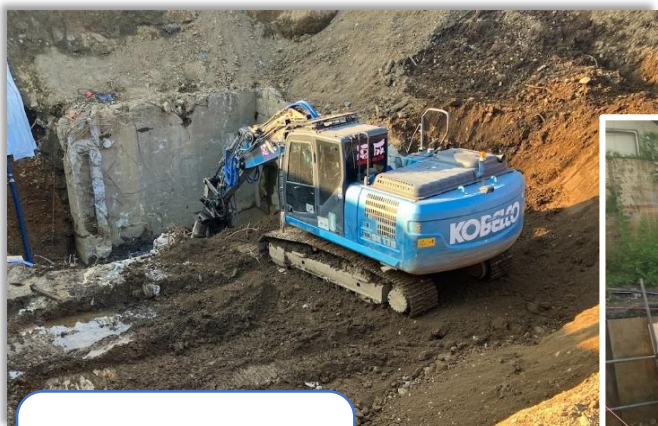
ごみピット解体の様子です
