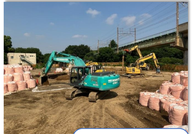
土壌汚染対策工事は順調に進んでいます
