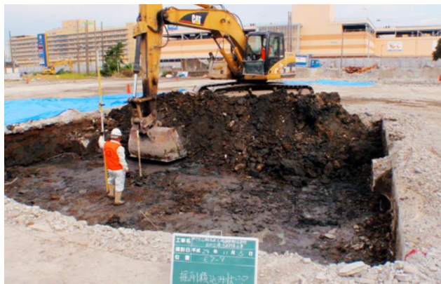
汚染土壌の掘削除去
