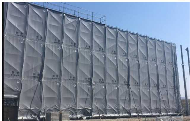
建物負圧養生
