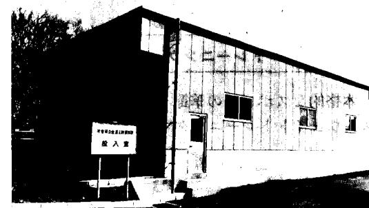
●投入場脱臭設備工事：し尿処理施設(昭和61年3月完成) 投入場の臭気対策を目的に既設投入室の建屋を撤去、新たに脱臭設備を要する投入室を設置(工事費 7,050万円)
