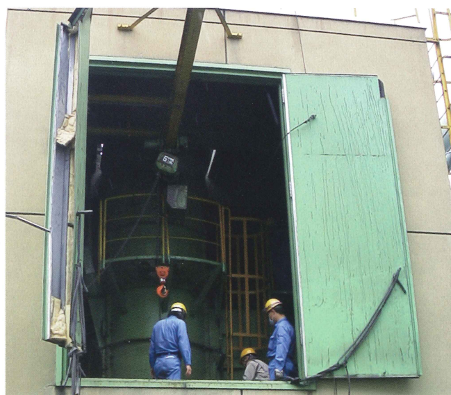
爆発で破損した破碎施設の扉
