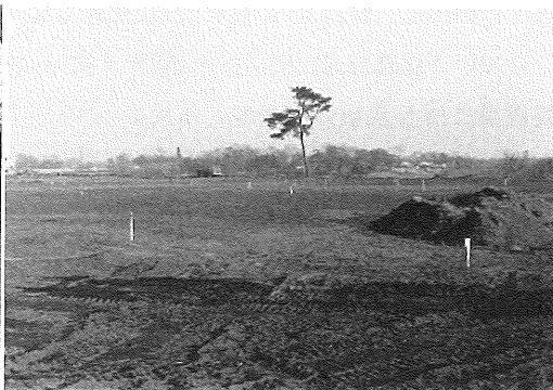
造成中の野球場
