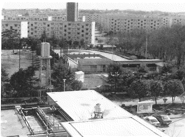
昭和50年代はじめ頃の屋外プール 手前し尿処理第1・2工場、向こうは久留米西団地
