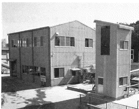
コンポスト用汚泥脱水設備
