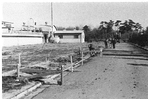
し尿処理第2工場の建設地 左が第1工場、右手はグラウンド(昭和44年1月)
