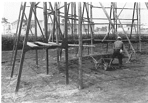
バックネット建設
