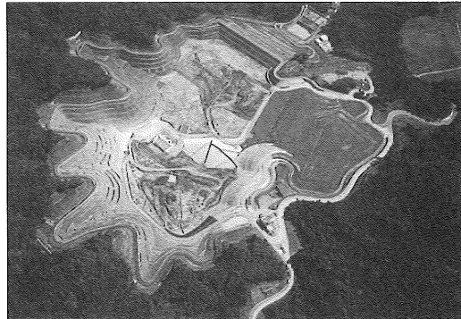
谷戸沢廃棄物広域処分場
