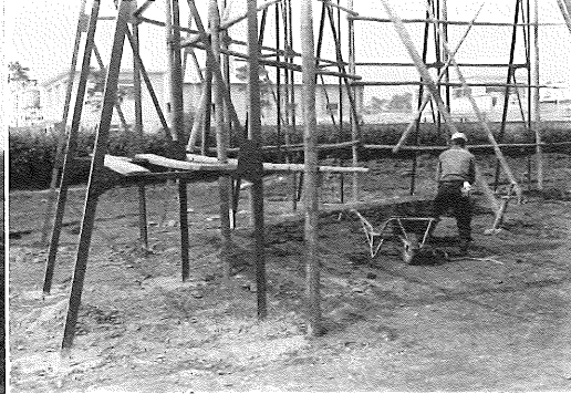
バックネット建設
